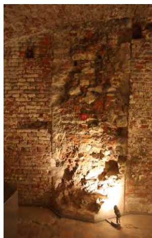
Intérieur d'un pilier ©M. Vanhulst.
