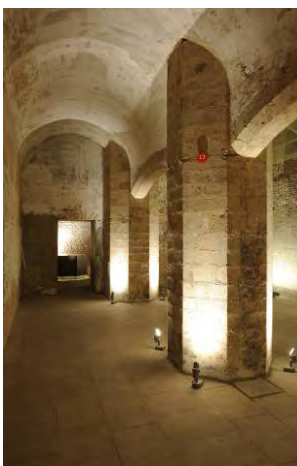
Piliers octogonaux ©M. Vanhulst.
