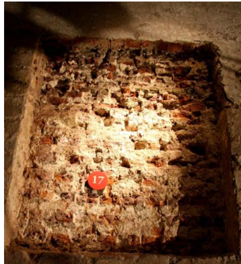
Dichtgemetseld venster © EGK
