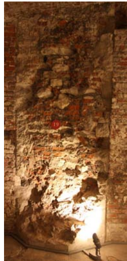
binnenzijde van een pilaar © EGK
